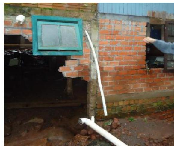
*Deslocamento de pilar de concreto causando rompimento deste.*
