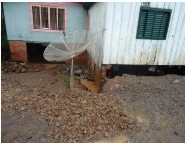
*Queda de muro de contenção, frontal à residência.*
