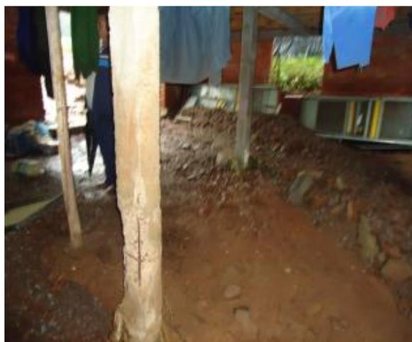
*Pilar de concreto com ferragem aparente e escora de madeira sustentando a viga de concreto de dimensionamento inadequado.*
